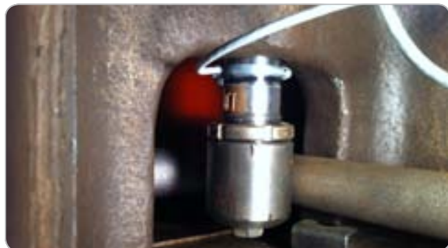
Obr. 8 Mechanizmus zabezpečenia nastavených parametrov, pripojovacia svorkovnica a tienená kabeláž
