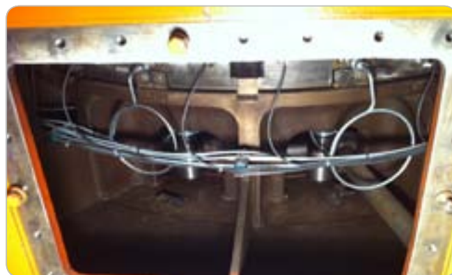
Obr. 7 Susedné prvky umožňujúce meranie tlaku na segmenty axiálneho ložiska
