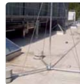
Obr. 3 Základňa vysokej samostatne stojacej zachytávacej tyče s kotviacimi lanami
